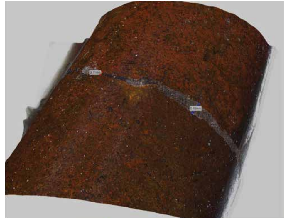
2306261227-Cristo brazo dch-fisura-medidas 3D.tif
